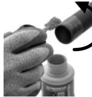
APPLIQUER LE HTA® FUSION SUR LE TUBE ET LE RACCORD
