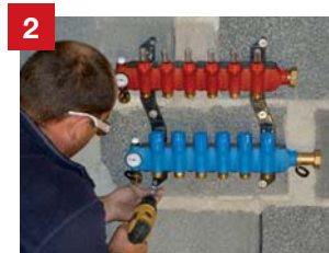
2 INSTALLATION DES COLLECTEURS
