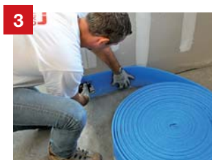
3 MISE EN PLACE DE L'ISOLATION PÉRIPHÉRIQUE
