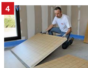
4 POSE DES PLAQUES ISOLANTES
