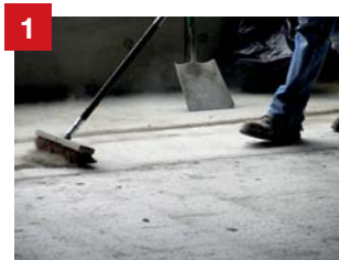
1 PRÉPARATION ET CONDITIONS PRÉALABLES
