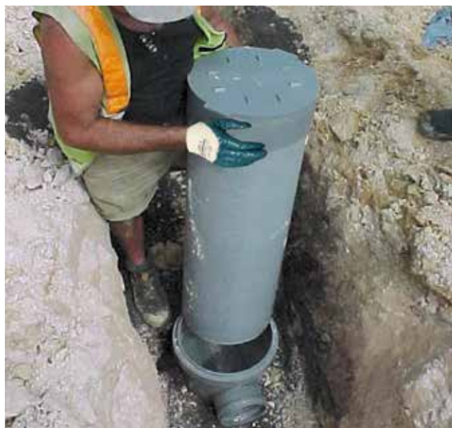
Exemple d'installation avec des regards d'égout en PVC :
