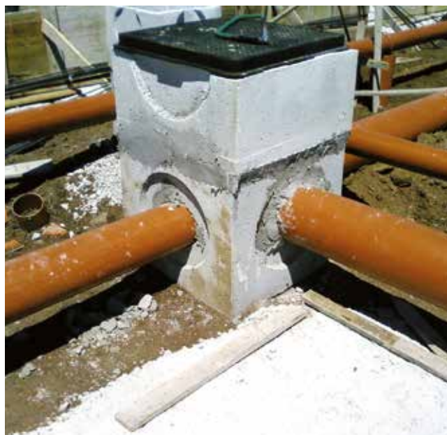
Exemple d'installation avec des regards et des extensions en ciment :
